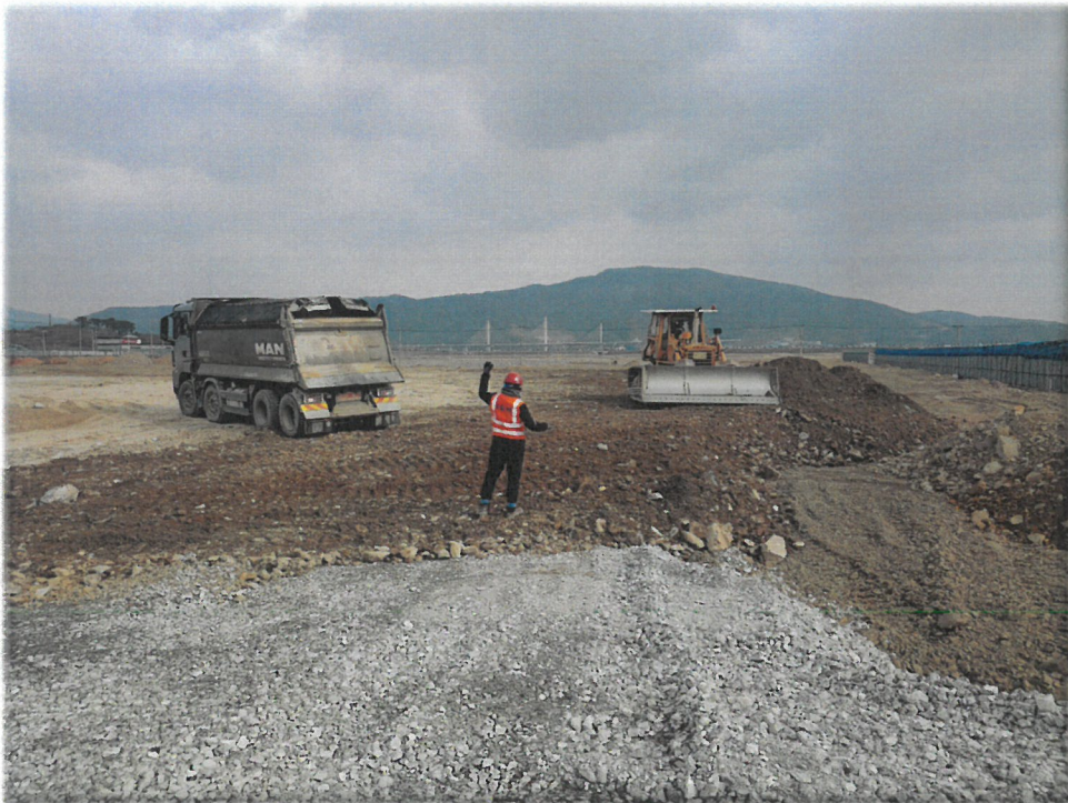
광양 세풍산업단지-㈜포스코 현장, 보조기충용 골재 공급
